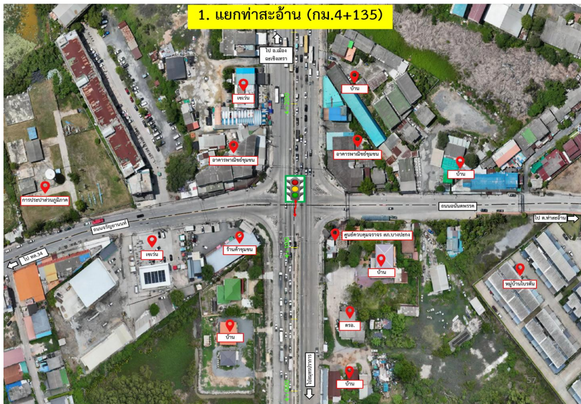
รูปที่ 9-5 สภาพทั่วไปบริเวณจุดตัดระหว่างทางหลวงหมายเลข 314 กับถนนจรัญยานนท์และถนนอนันตพรต (แยกท่าสะพาน)
