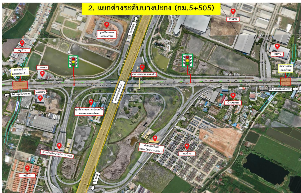
รูปที่ 9-7 สภาพทั่วไปบริเวณจุดตัดระหว่างทางหลวงหมายเลข 314 กับทางหลวงพิเศษระหว่างเมืองหมายเลข 7 (ทางแยกต่างระดับบางปะกง)
